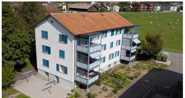
Attinghauserstr. 58 + 60 Baujahr 1951/52 Abbruch und Ersatzneubau geplant Ende 2025 bis Herbst 2027
